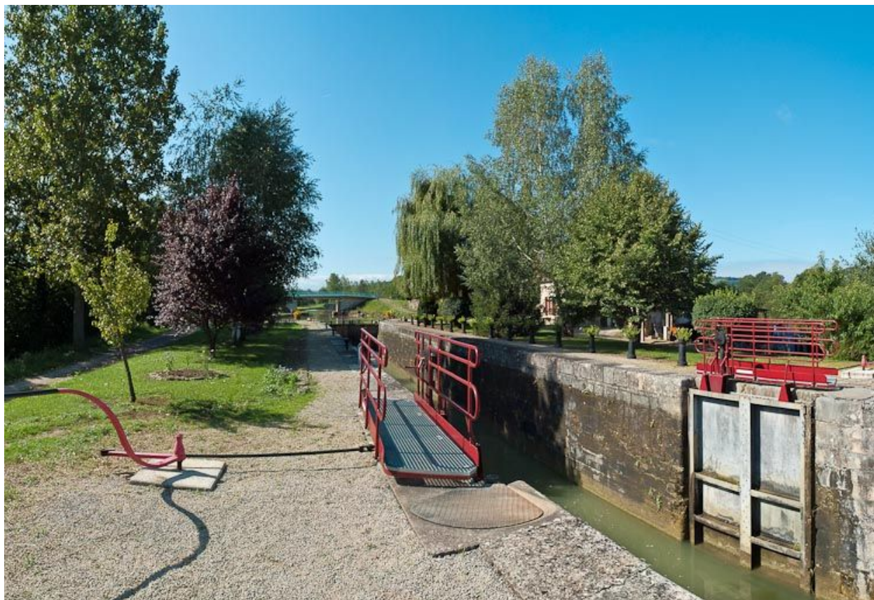
Vue du sas d'écluse.
