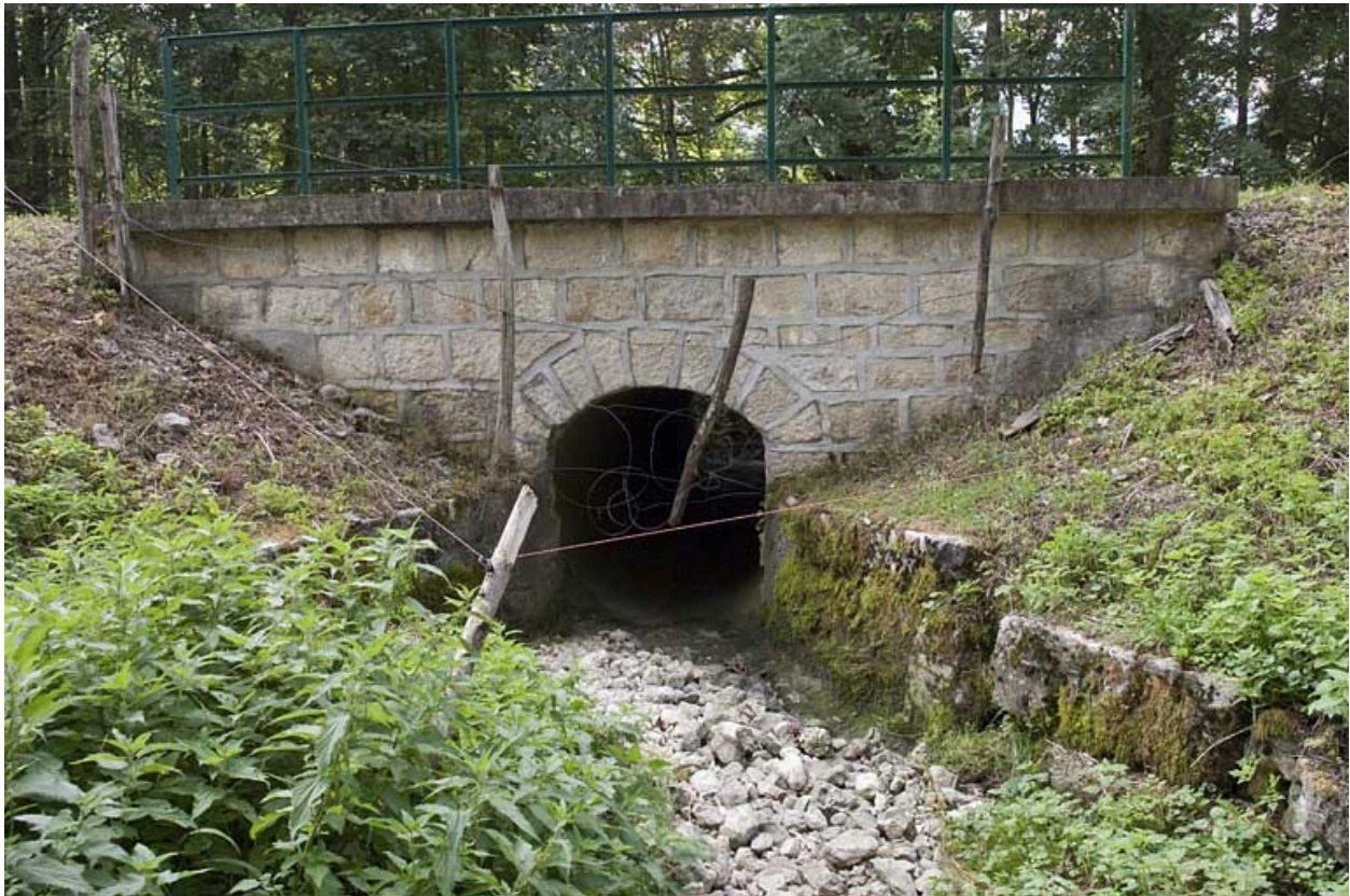
Pont sur la Servante (n° 5), vu depuis l'amont.
