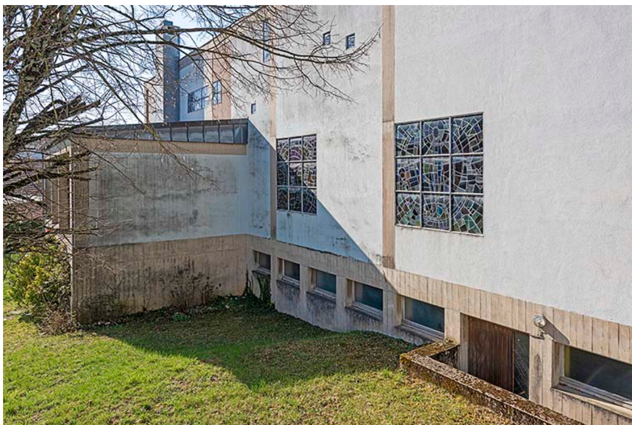
Façade nord-est. Détail.
