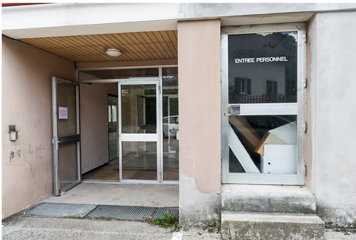
Usine : entrée sur la façade antérieure.
