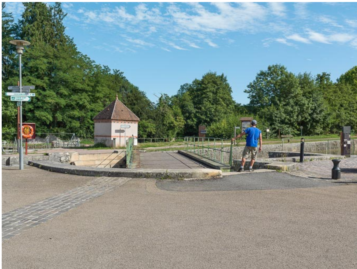
Vue du pont, manoeuvré par l'éclusier.
