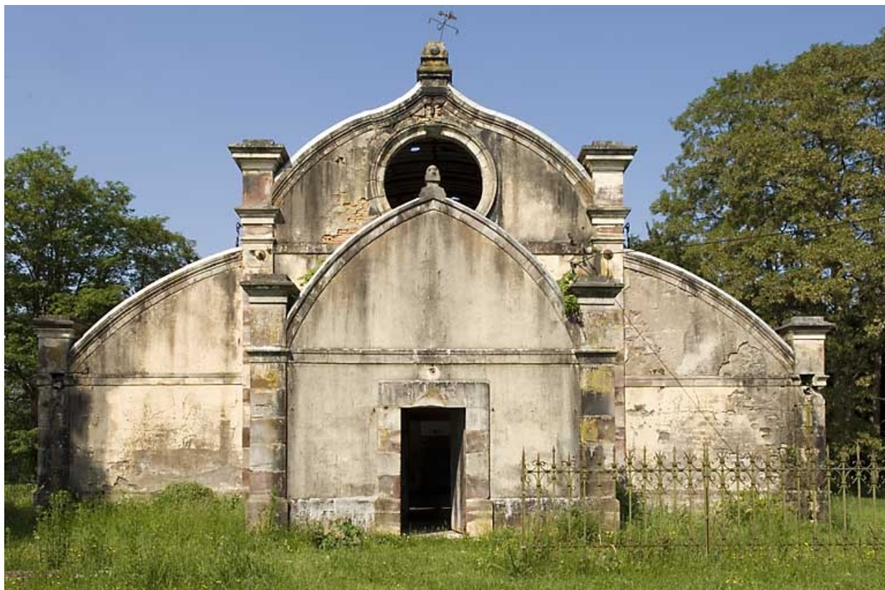
Serre. Mur-pignon est.
