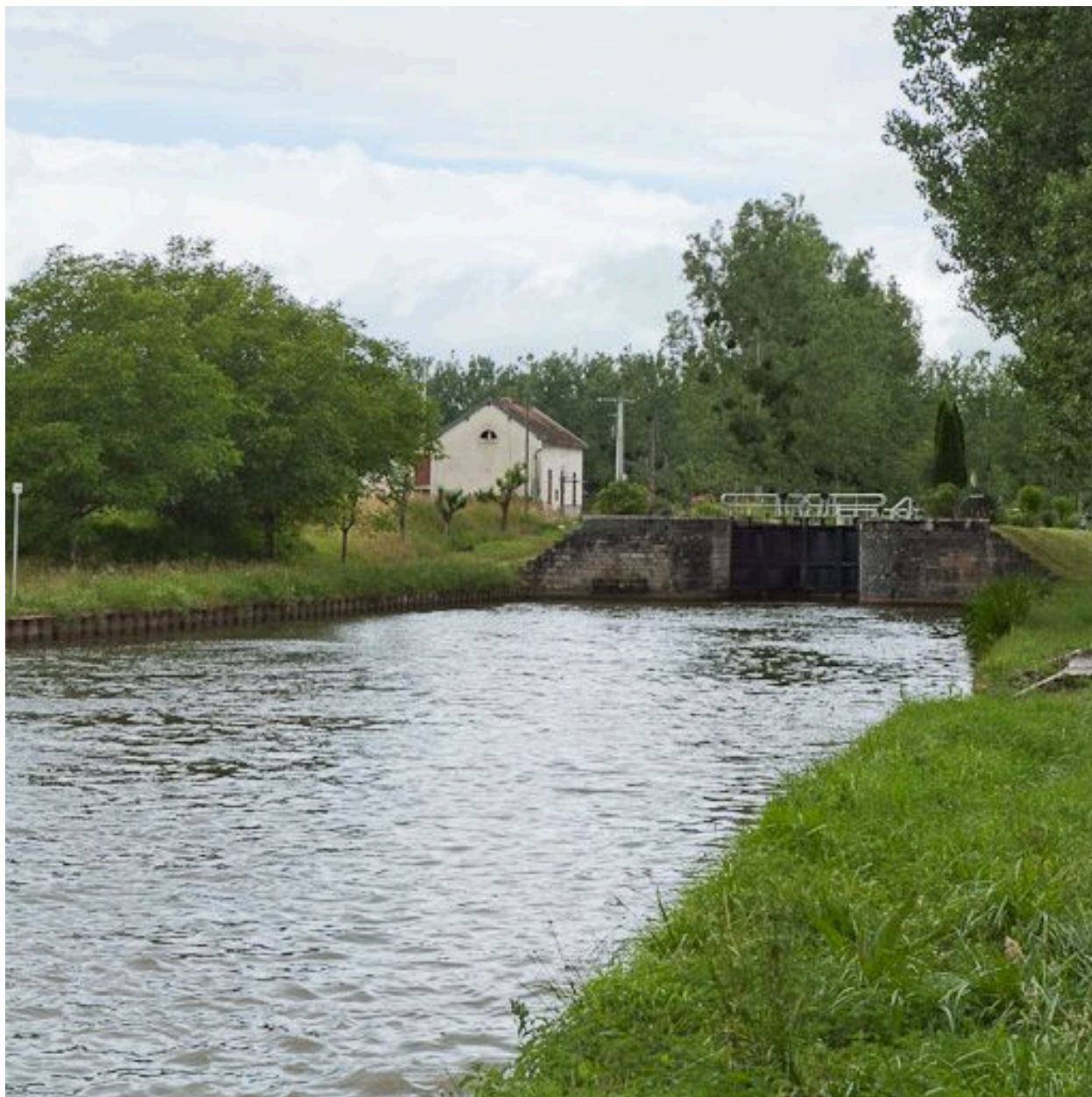
Site d'écluse vu depuis l'aval.
