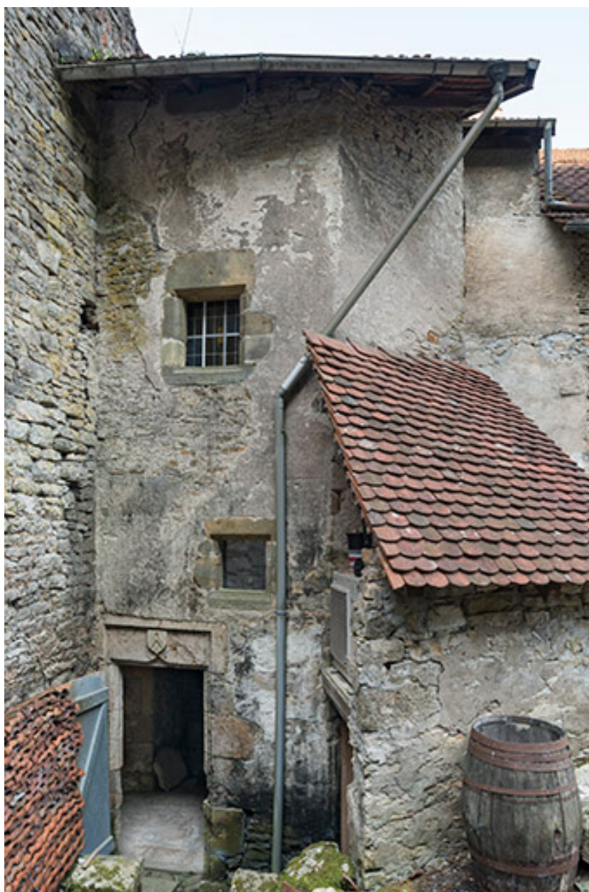
Tour comprenant l'escalier, côté cour.
