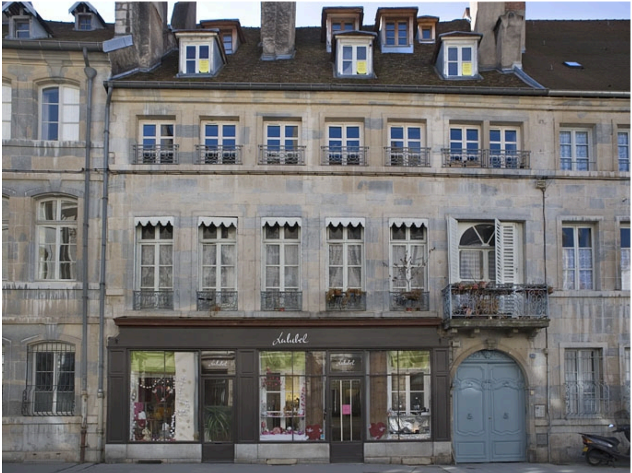
Vue d'ensemble de la façade sur rue, de face.
