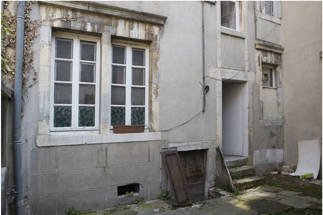
Façade postérieure du logis principal sur rue, partie droite : détail des fenêtres du rez-de-chaussée.
