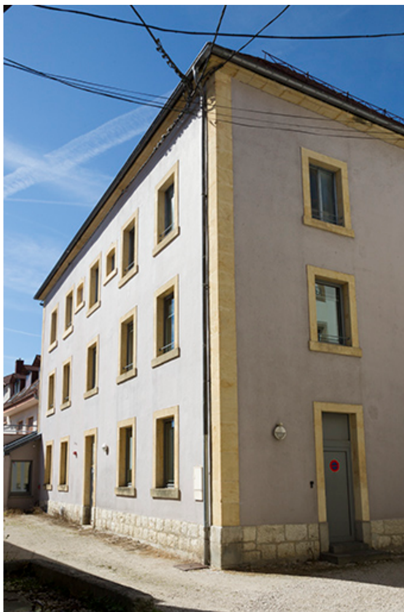
Façade postérieure, vue en enfilade.
