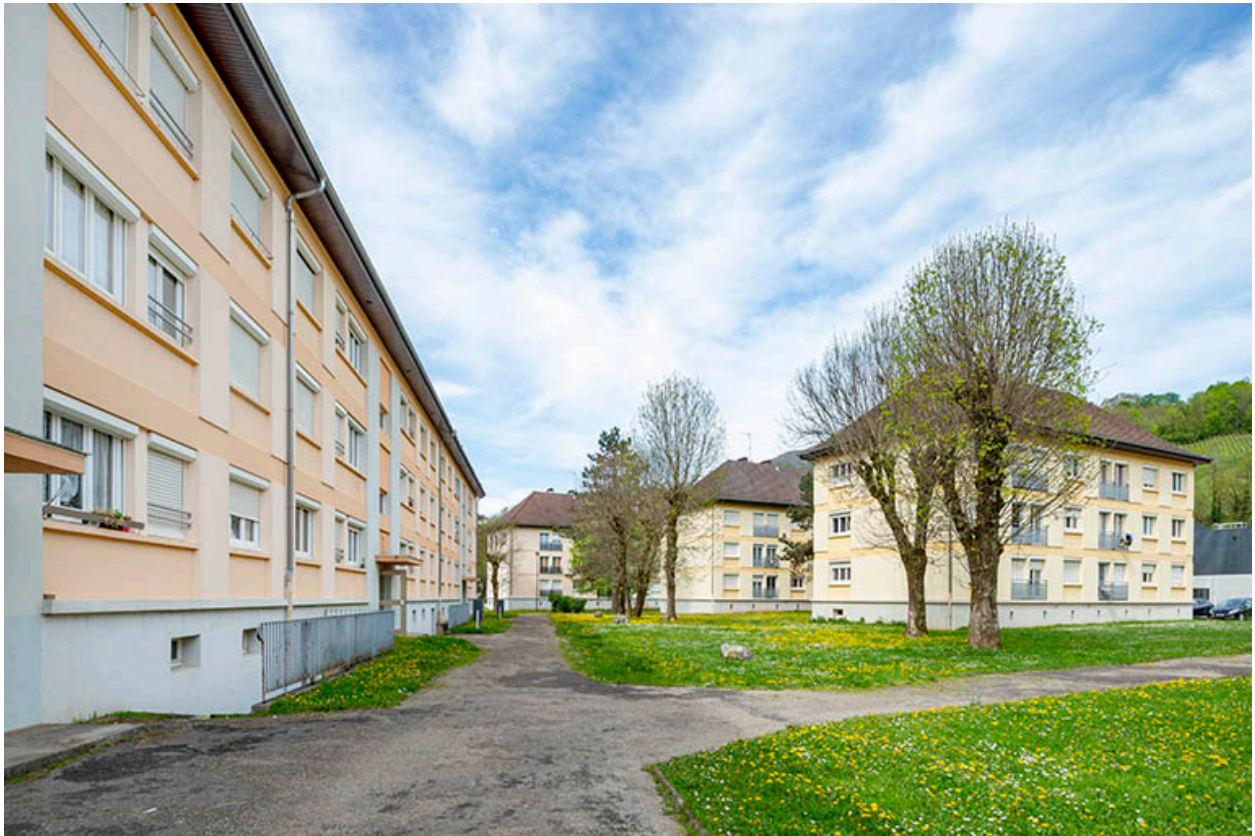
Vue d'ensemble depuis le sud du bâtiment Saint-André.
