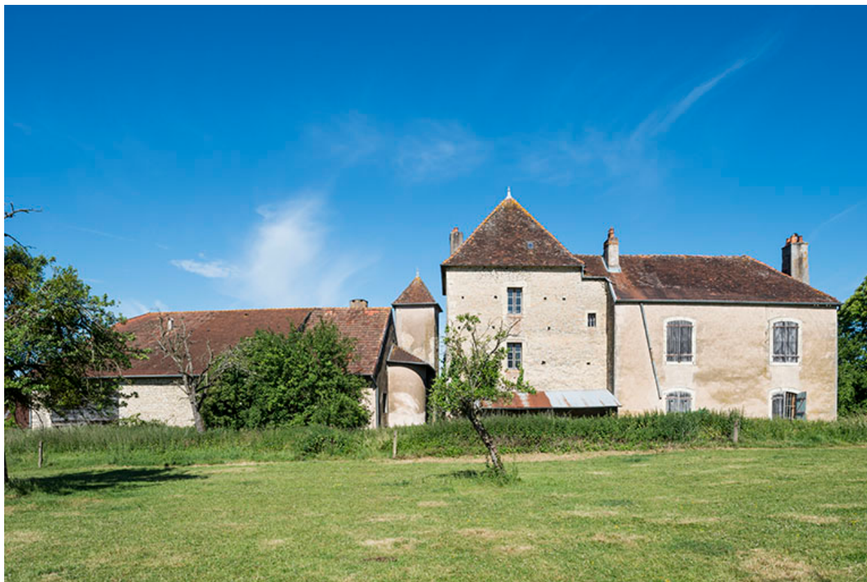
Vue d'ensemble de la façade postérieure.
