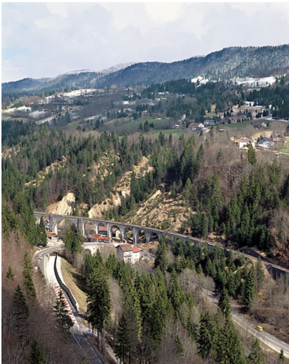
Viaduc de l'Evalude (Morbier) : vue d'ensemble plongeante, depuis l'ouest.
