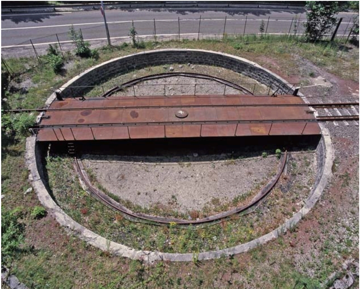
Vue d'ensemble plongeante, depuis l'est.
