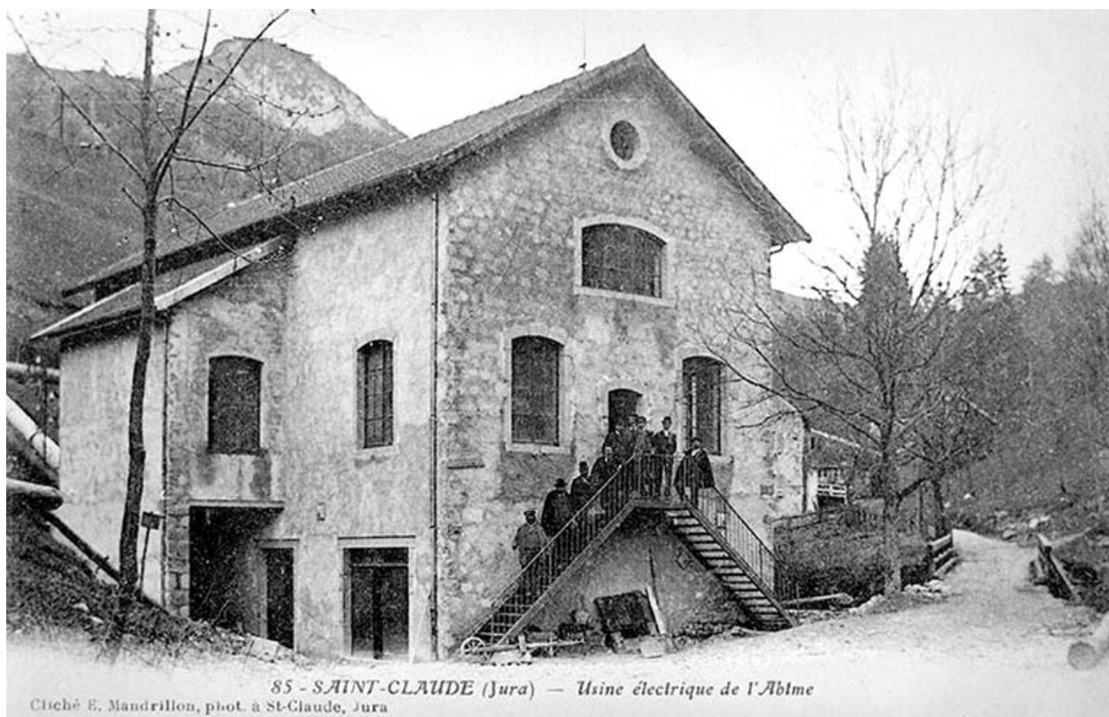
Saint-Claude (Jura) - Usine électrique de l'Abîme.
