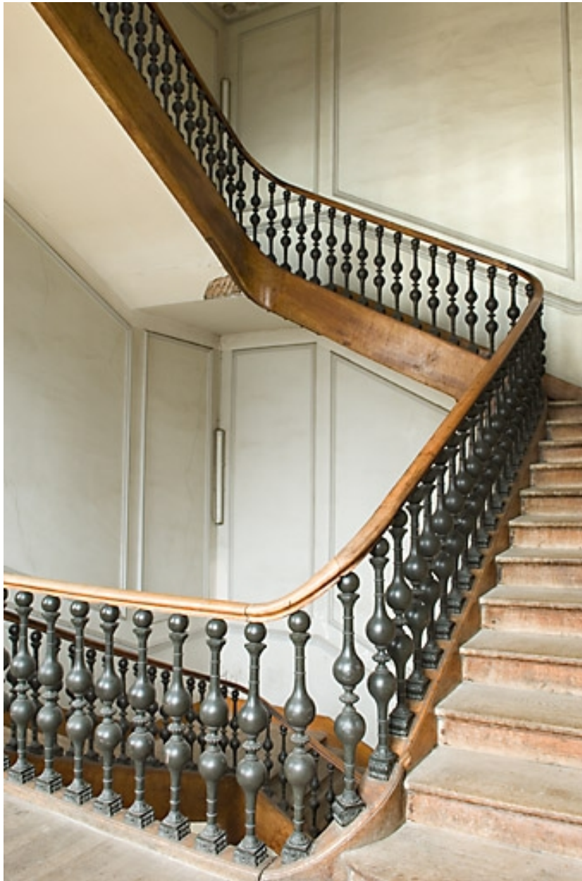
Escalier d'honneur : vue d'ensemble.
