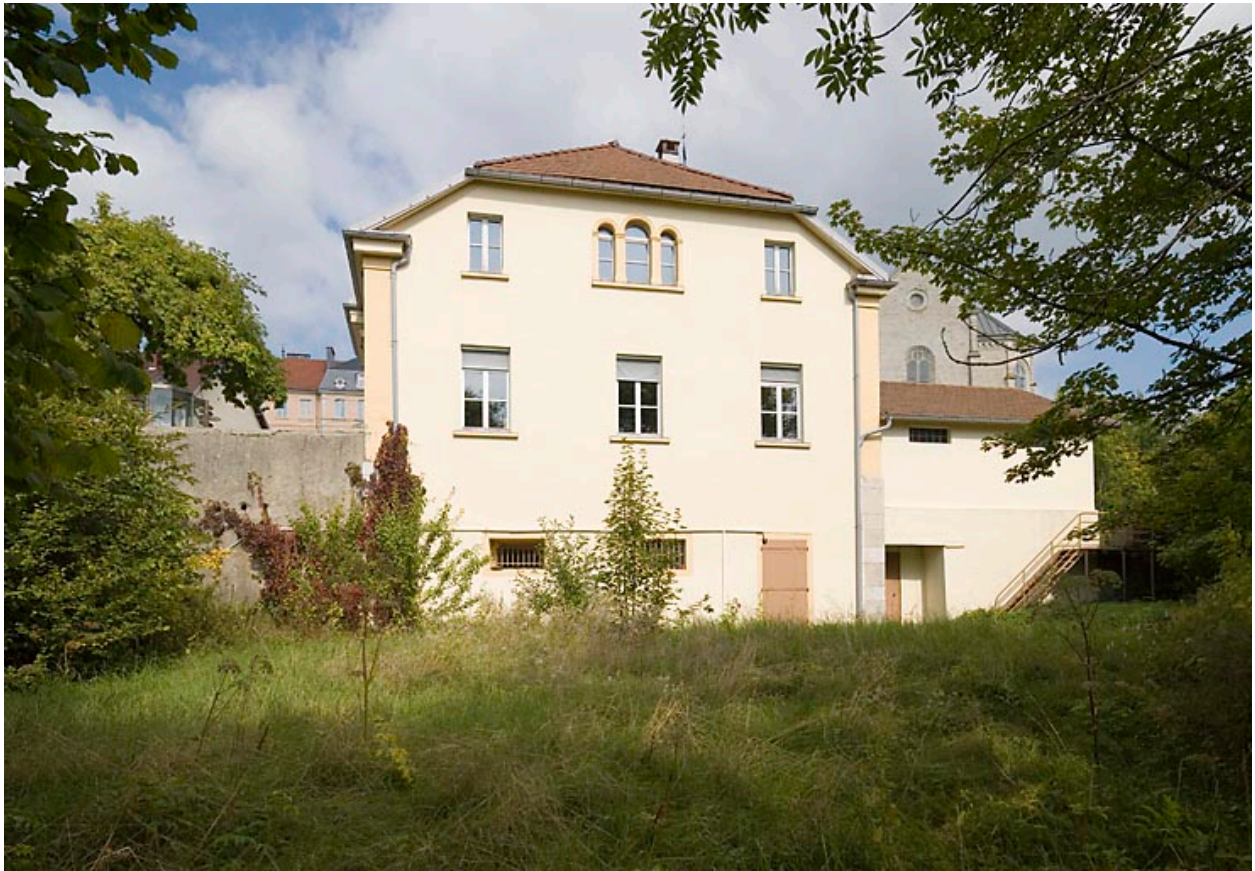
Façade latérale droite.
