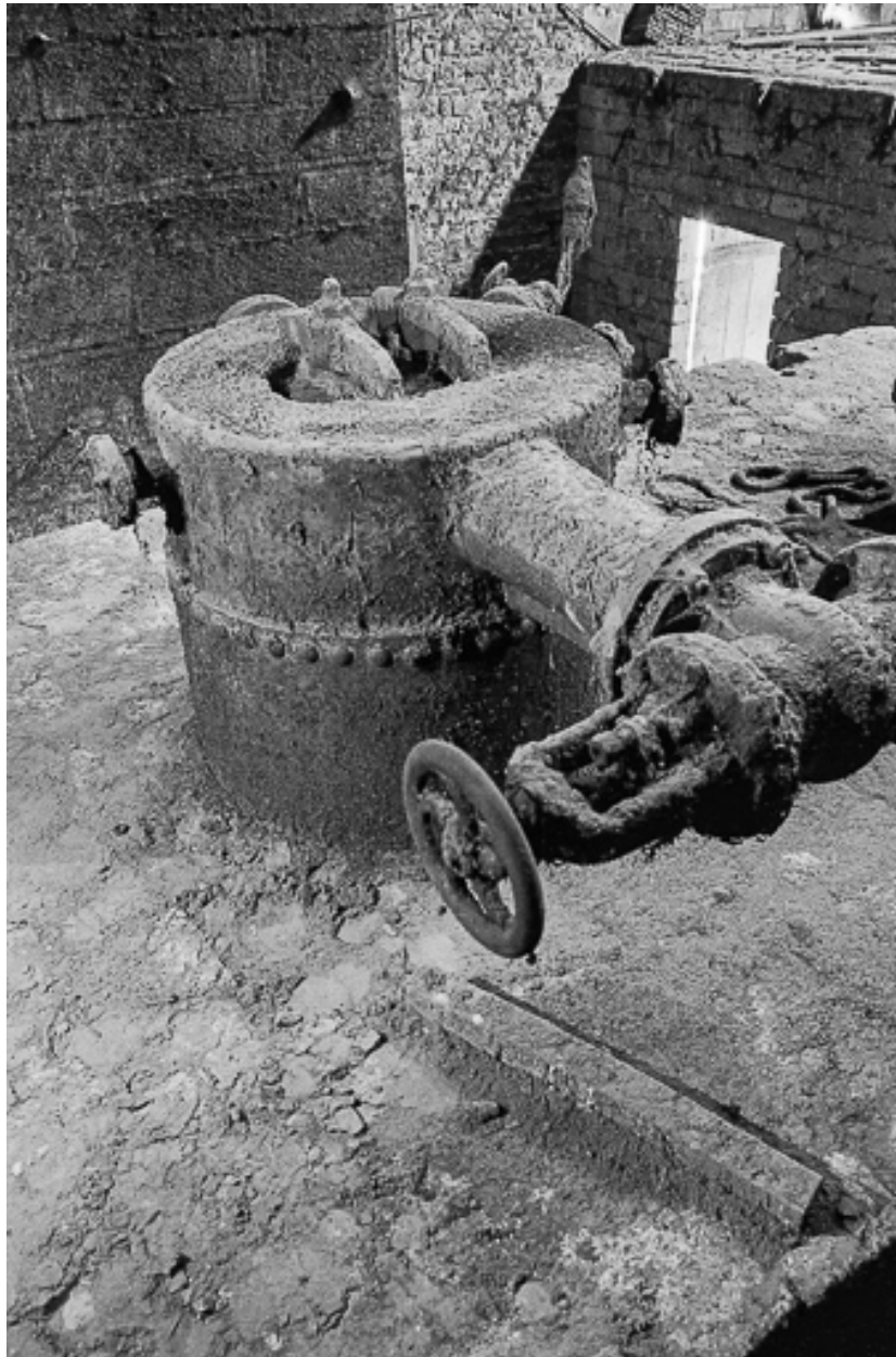
Partie supérieure de la chaudière. Vannage.
