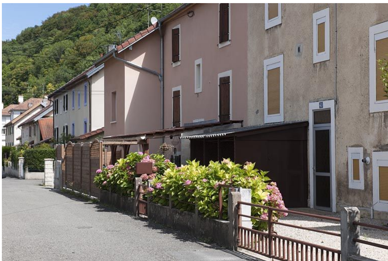
Façades ouest d'habitations ouvrières.
