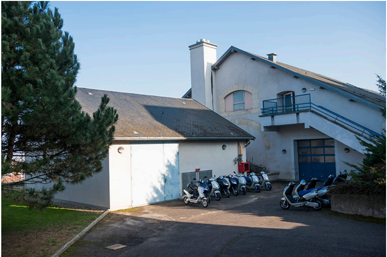
Angle nord-ouest de la chaufferie principale et pignon nord de l'ancien manège-atelier.
