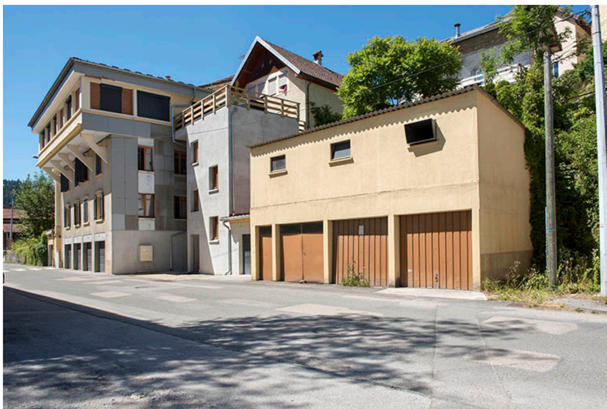
Site ancien, vu du nord.
