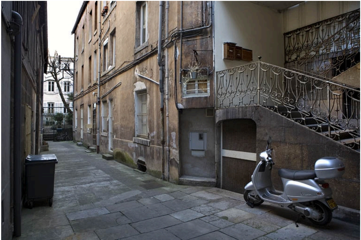
Vue d'ensemble du logis secondaire situé à droite de la première cour.
