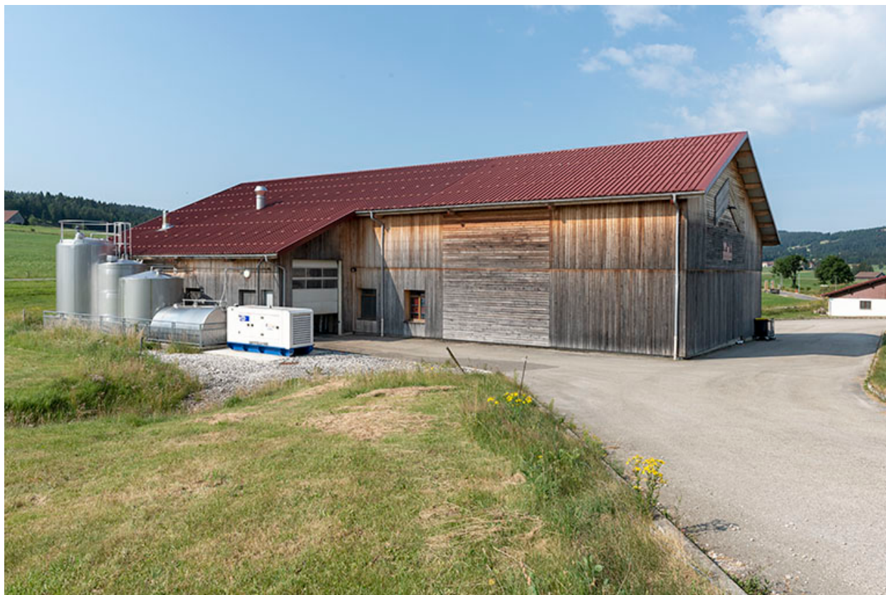
Façades postérieure et latérale droite.
