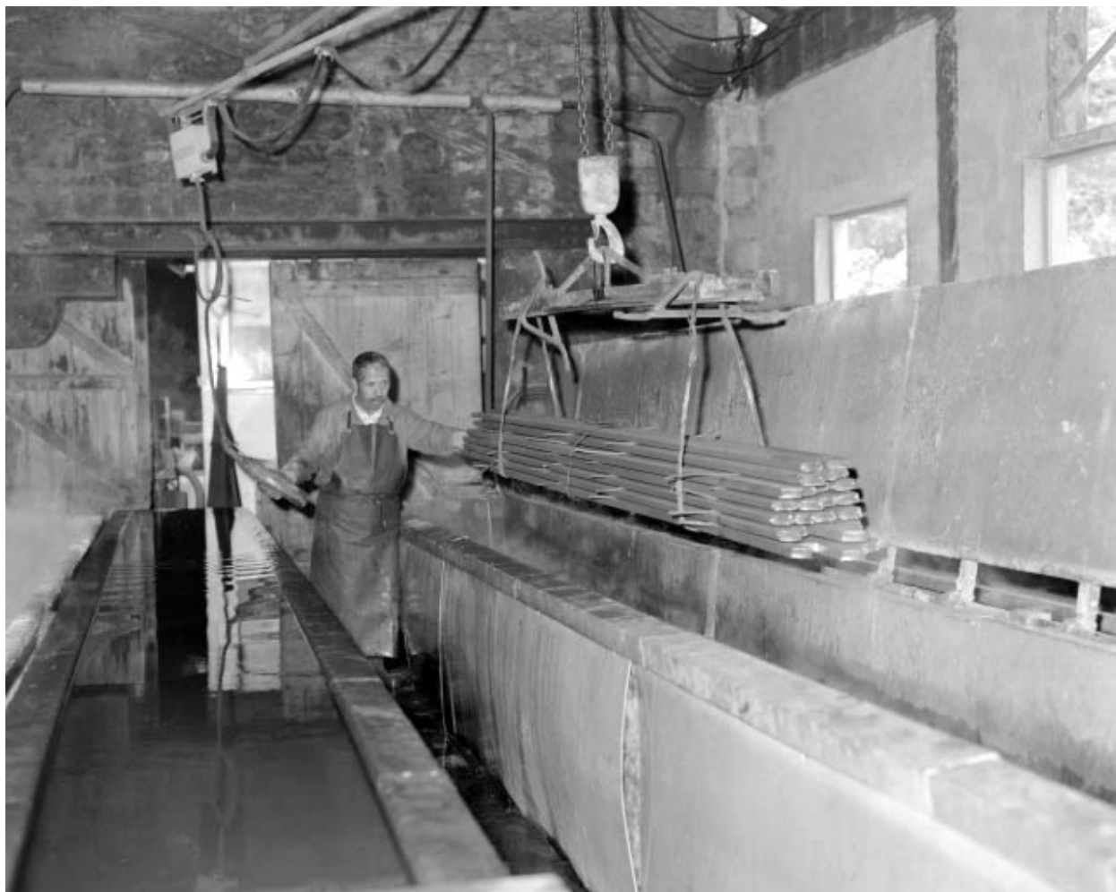
Atelier de décapage : déplacement des barres.
