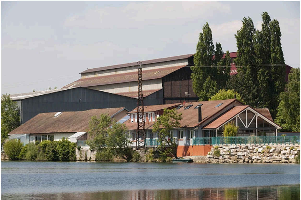
Bâtiments de l'aciérie depuis le sud-est.
