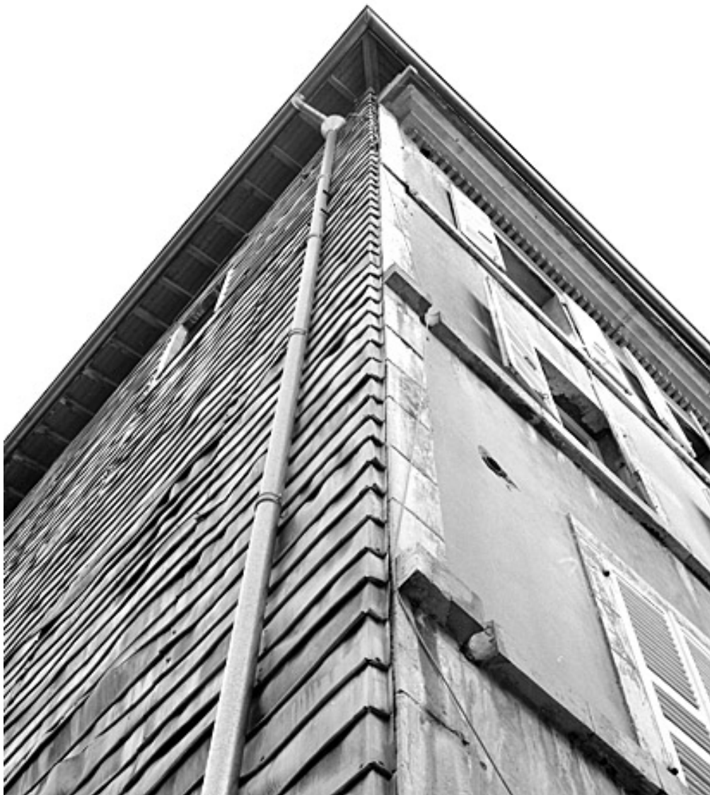
Angle des murs sud et est.
