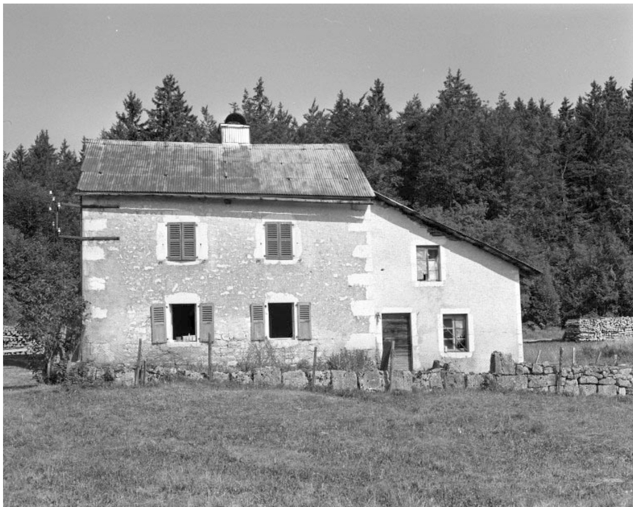
Façade antérieure de la maison de douaniers.
