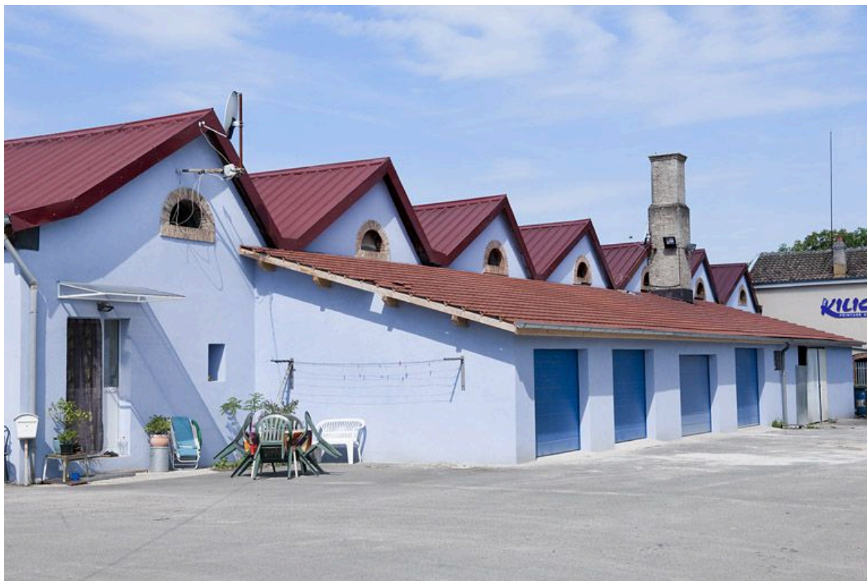
Pignons de l'atelier de fabrication.
