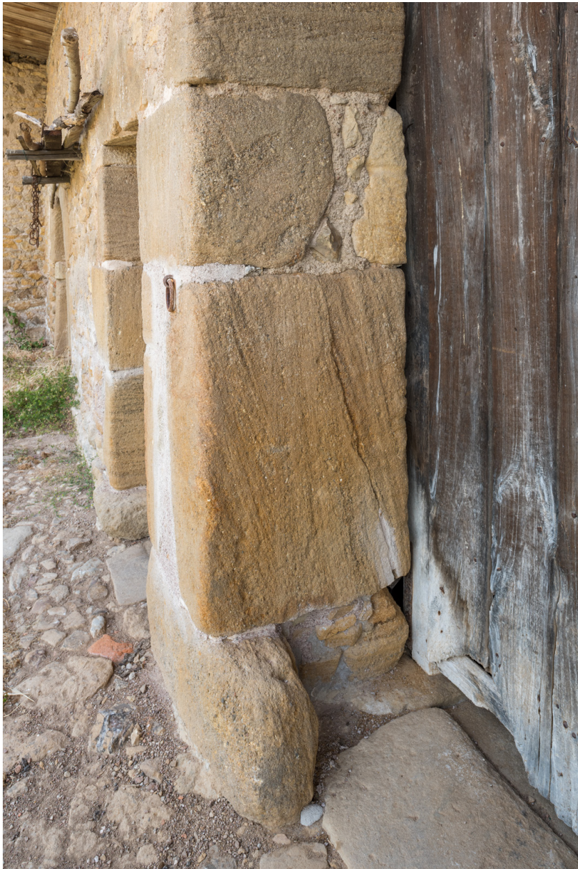
Bâtiment agricole. Piédroit de la porte de remise.
