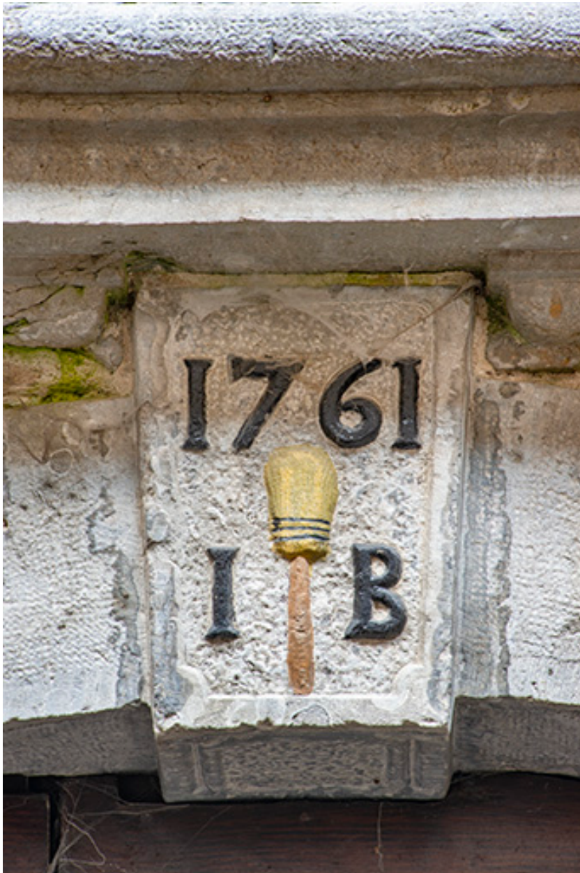
Détail du linteau de la porte d'entrée.
