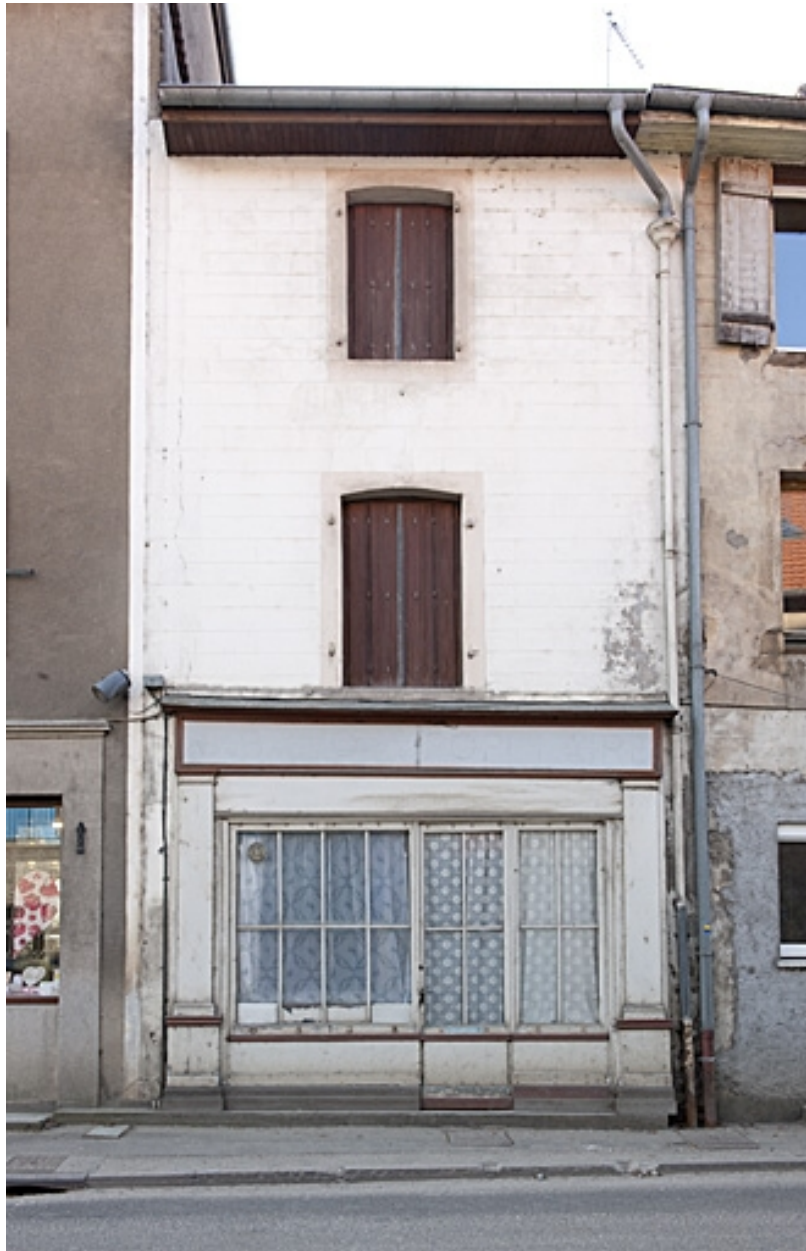
Ancien magasin de commerce au 8 rue du Vieux Moulin (2010 AL 136).
