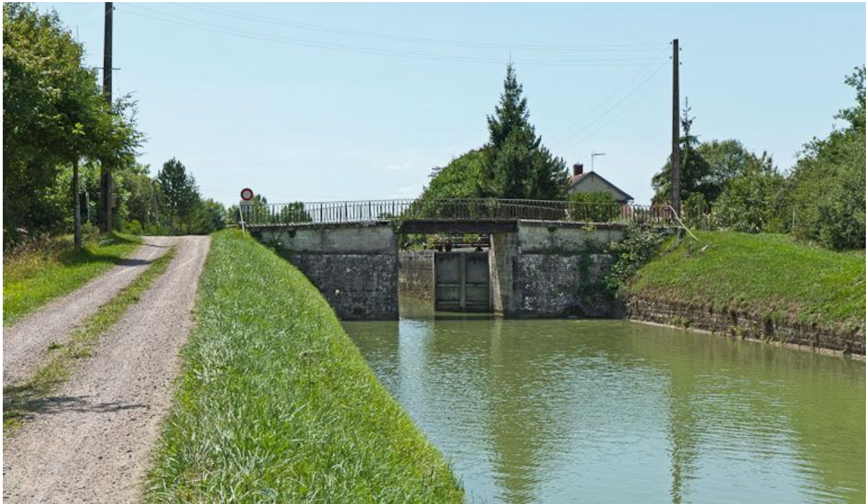
Vue du pont depuis l'aval.
