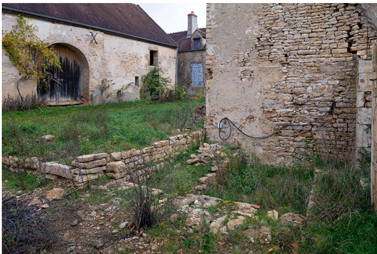
Ruines de la remise, contre le pigeonnier.
