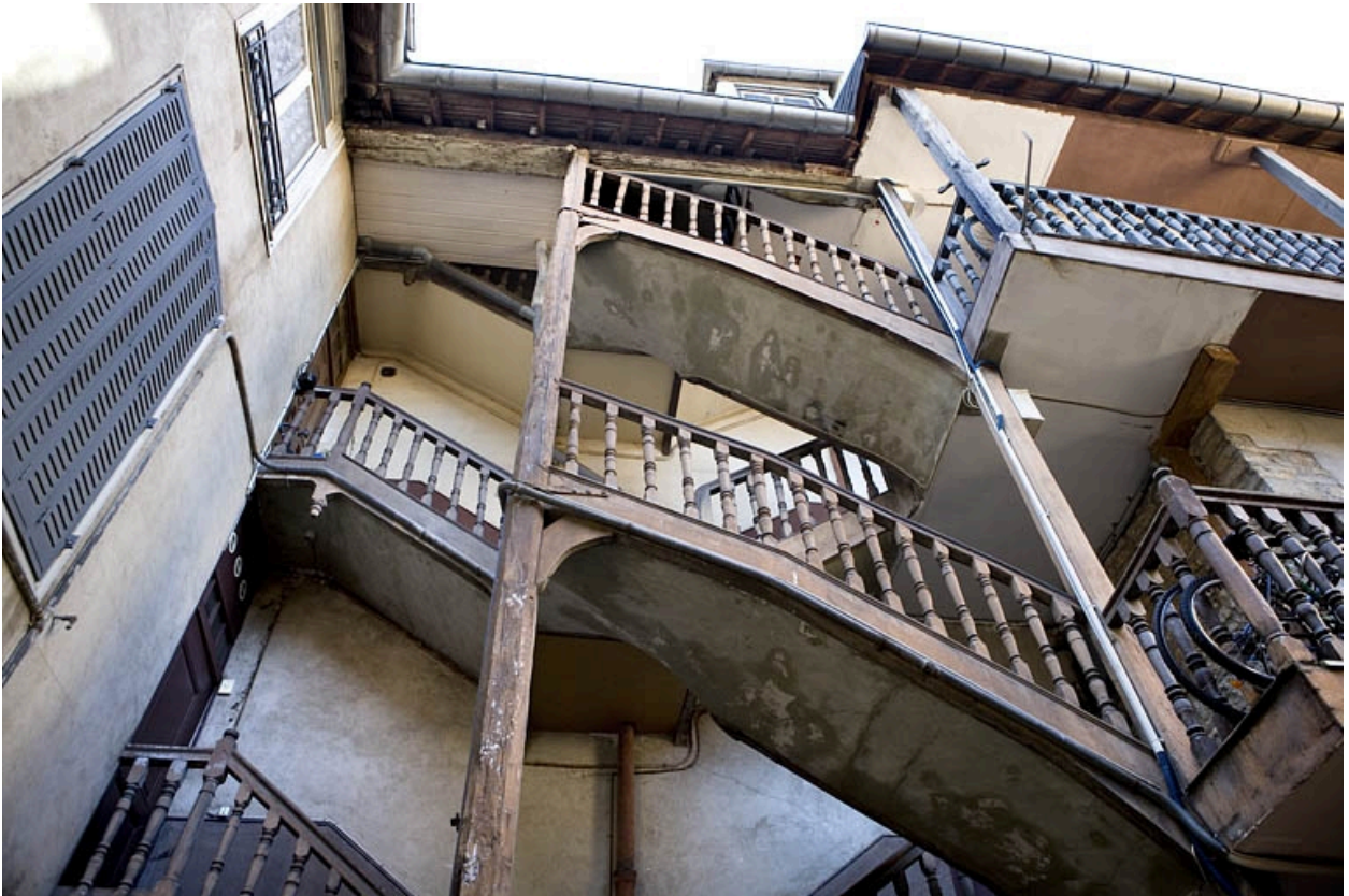
Détail de l'escalier à cage ouverte.
