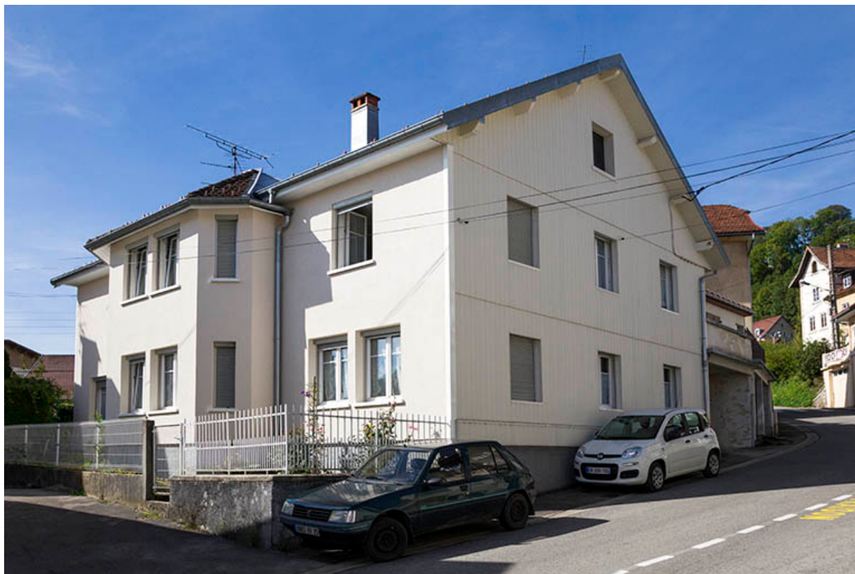
Façades antérieure et latérale gauche.
