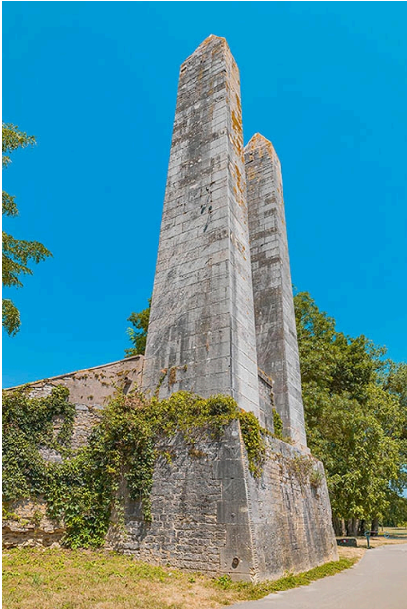
Pylônes de la rive droite, le long de la digue de Chauvort. Echelle de crue.
