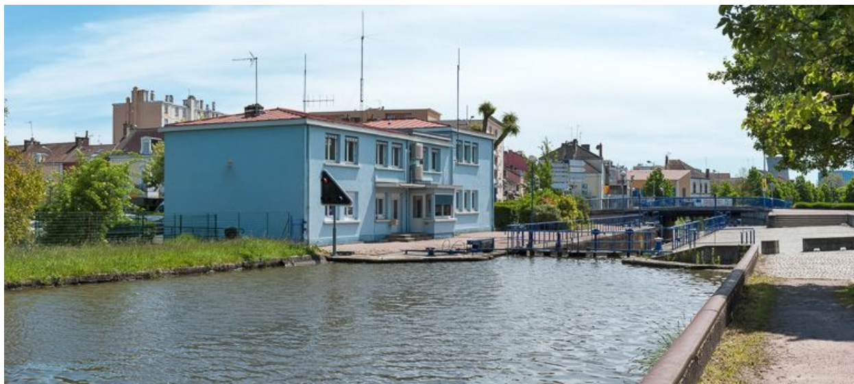
La subdivision de Montceau-les-Mines.
