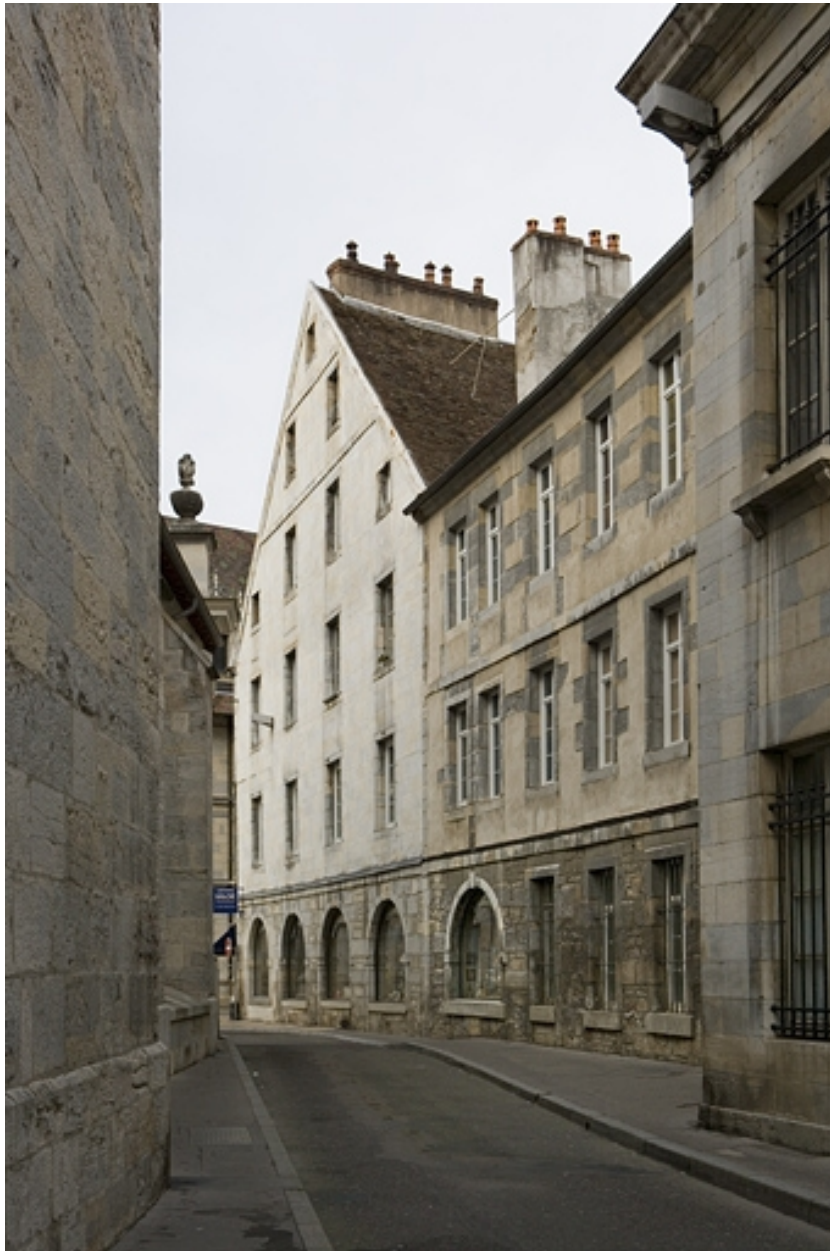
Détail de la façade latérale du logis principal et du logis secondaire depuis la rue de la Bibliothèque.
