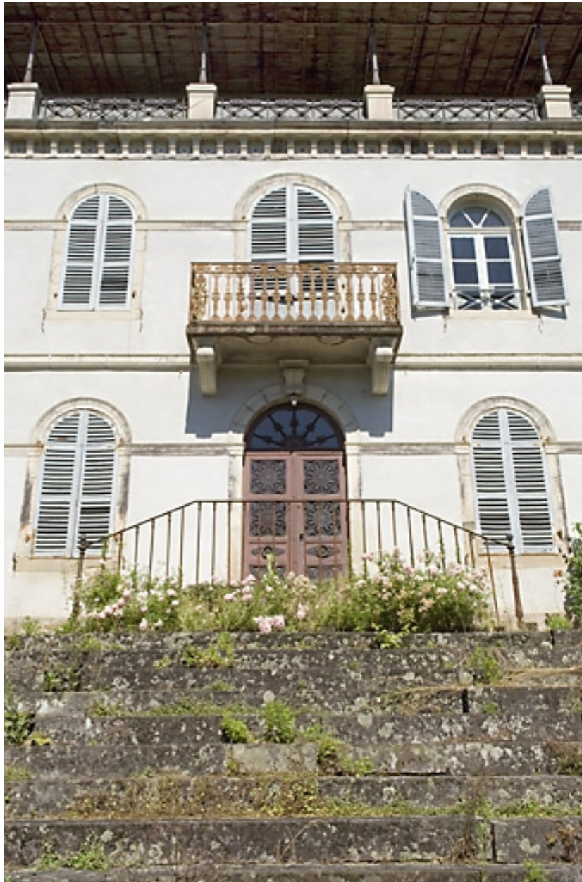
Logement patronal nord. Détail des travées centrales.
