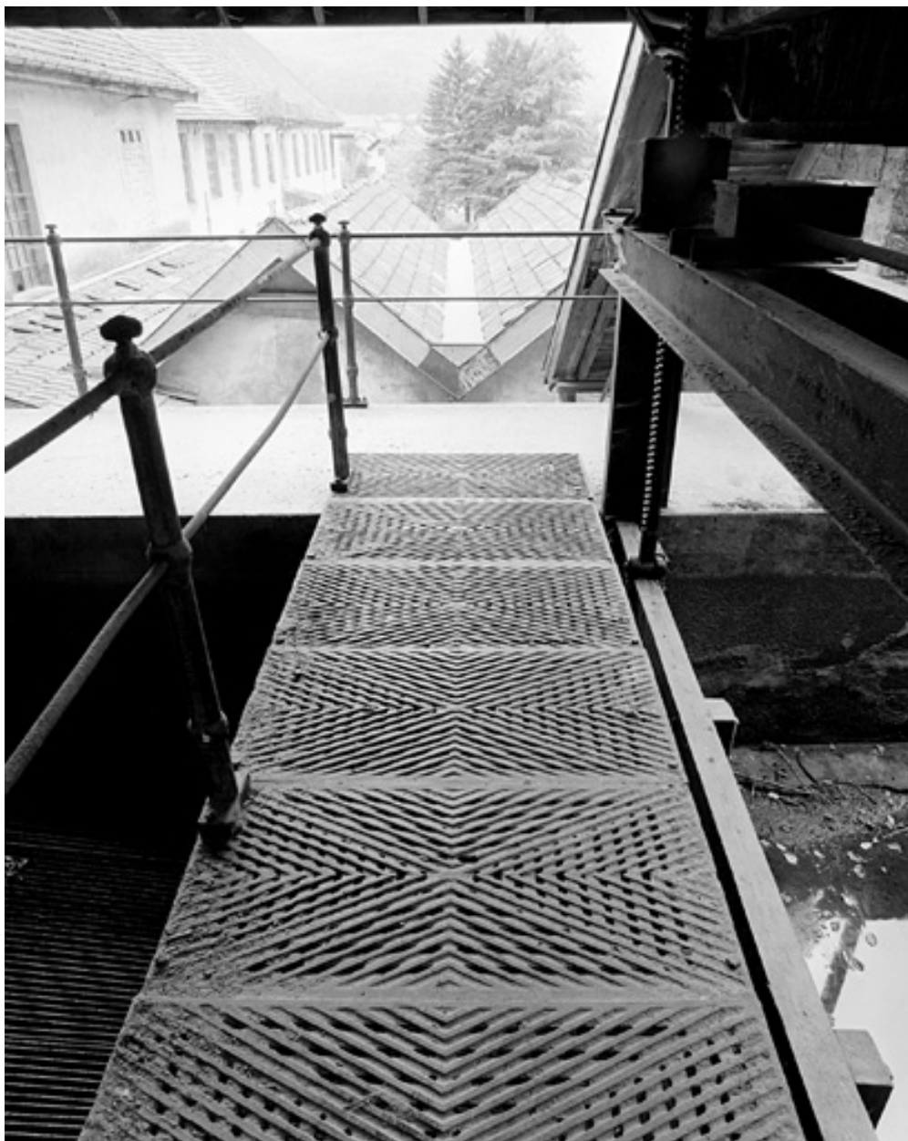
Passerelle sur le canal.
