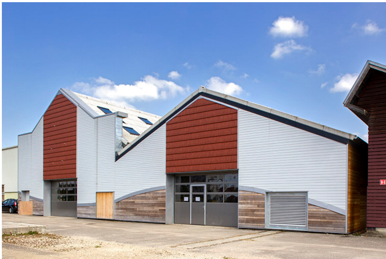
Ateliers : façade antérieure.
