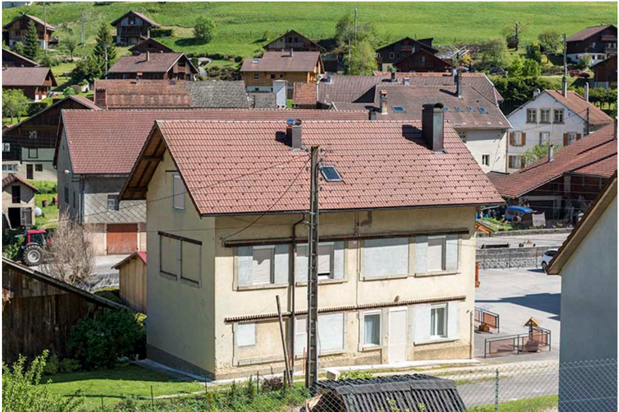
Façades postérieure et latérale gauche.
