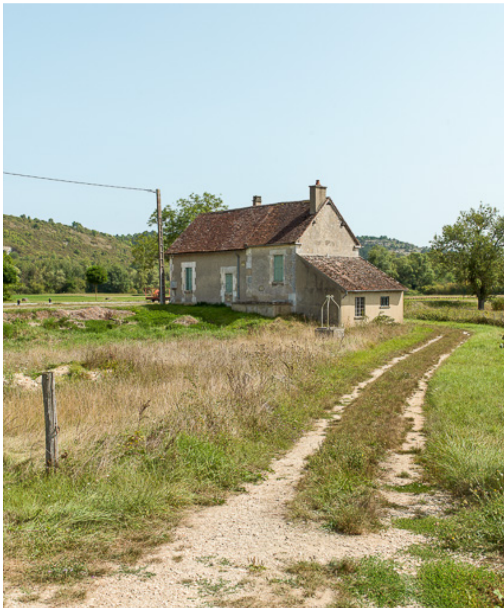
Vue de la maison éclusière.
