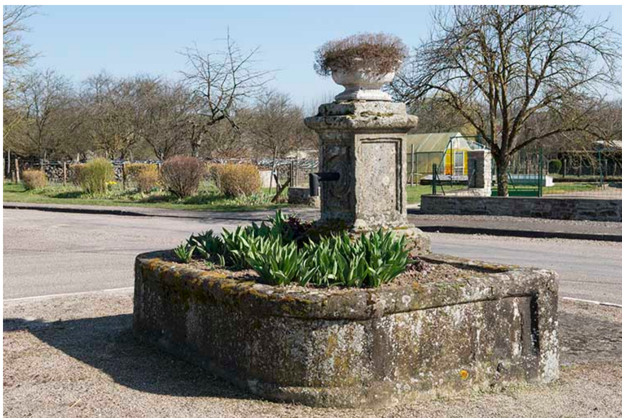
Le bassin maçonné de la fontaine.
