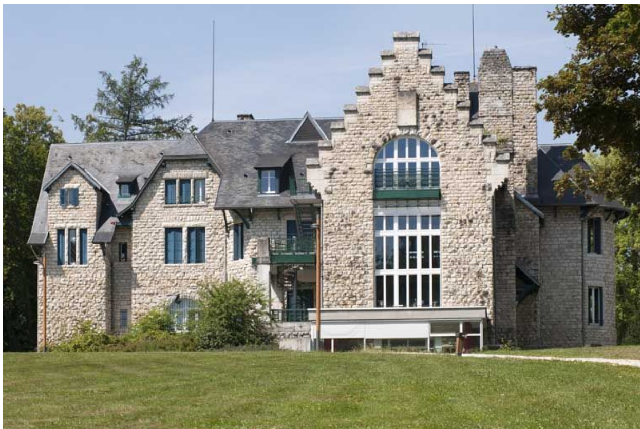
Façade postérieure depuis l'est.
