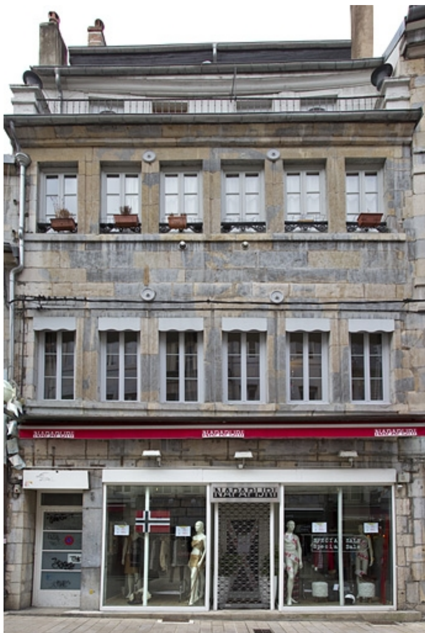
Logis principal, façade antérieure : de face.
