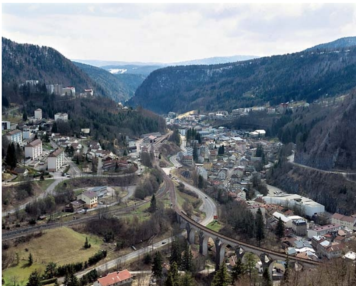
Vue d'ensemble depuis le viaduc des Crottes.
