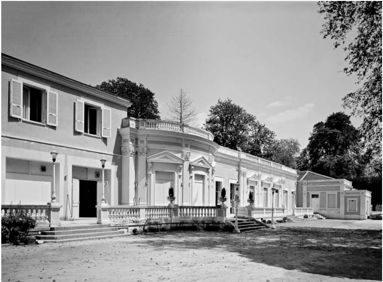
Façade, vue depuis le nord-ouest.
