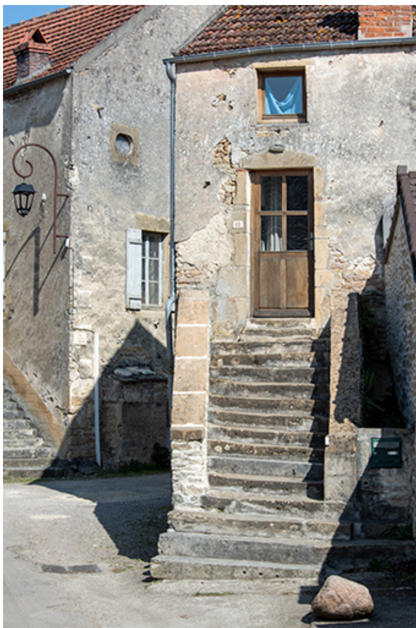
L'escalier d'accès de face.
